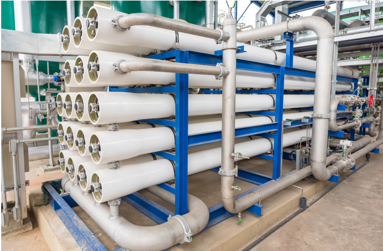
Figura 6. Sistema modular de osmosis inversa
