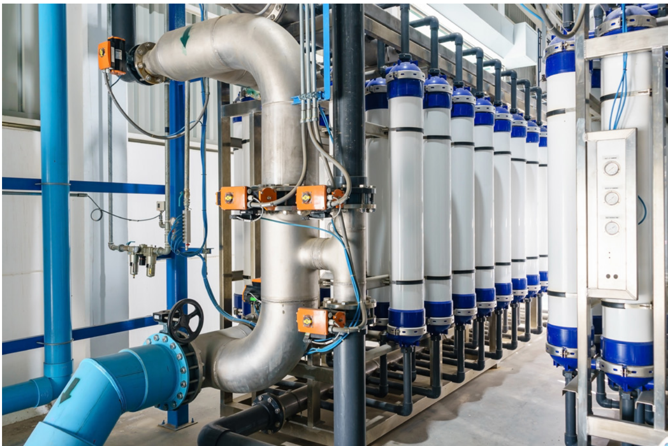
Figura 5. Sistema de pretratamiento mediante cartuchos
