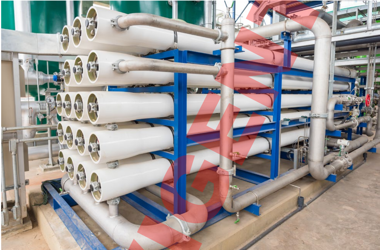
Figura 6. Sistema modular de osmosis inversa
